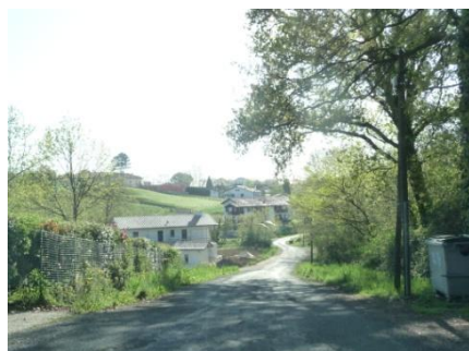
Construction en partie haute des vallons (chemin de Pétabure)
