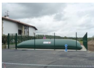
Bâche de stockage près de la Nive
