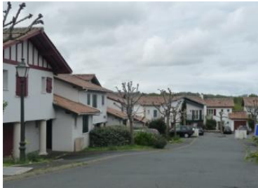
Construction à l'alignement
