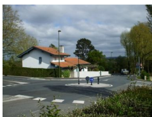
Aménagement d'un rond-point
