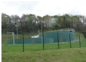
La station d'épuration
